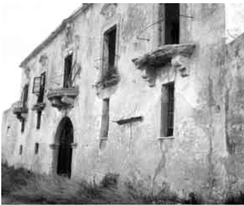
IL BAGLIO ABBANDONATO DI CONTRADA SELVAGGI
